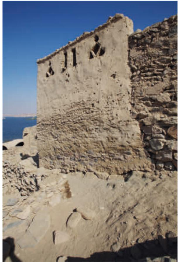
2 *Bāb*, WE 10, Scheuerspuren der Ziegen im untersten Bereich der Fassade
