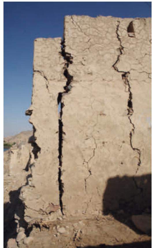
4 *Bāb*, WE 17, Vertikalrisse im Lehmziegelmauerwerk
