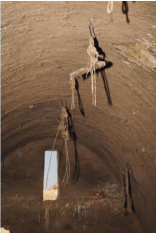
2 *Bāb*, WE 17, Metallschlingen im Tonnengewölbe
