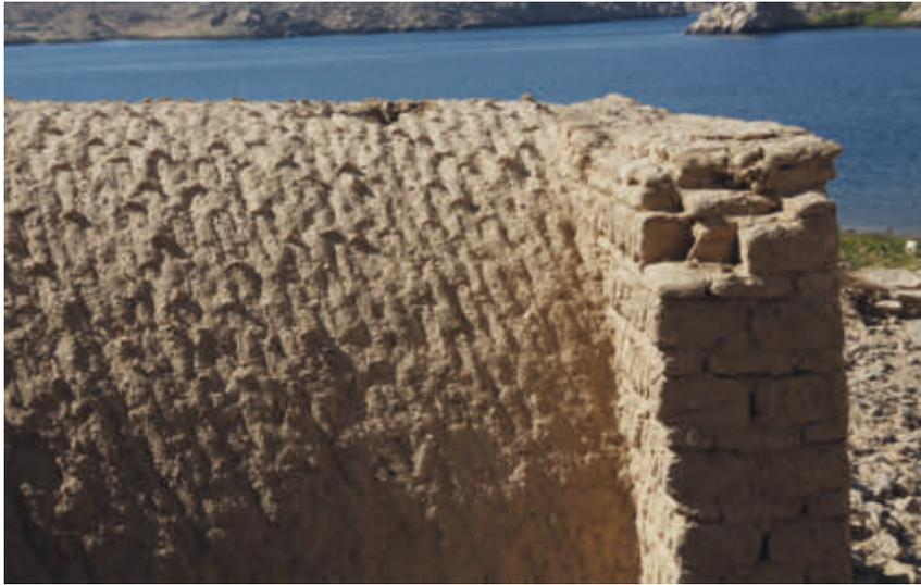
1 *Bāb*, WE 6, geneigte Ringschichten des Tonnengewölbes
