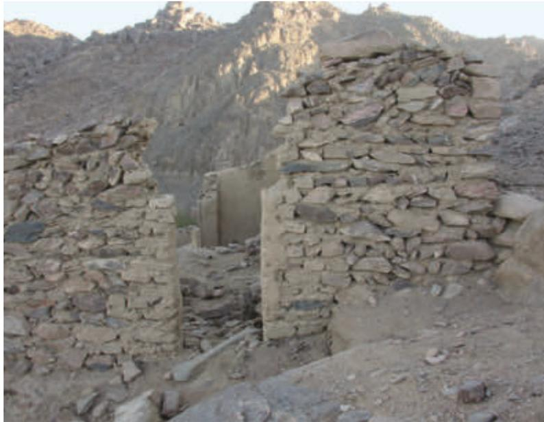
1 *Al-Ġūwānī*, WE 11C, Türlaibung aus Lehmziegel in Bruchsteinmauerwerk
