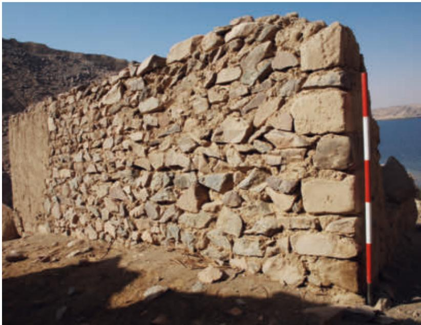
3 *Bāb*, WE 3B, Mauerecke aus Bruchsteinen und sekundär verwendeten griechisch-römischen Tempelblöcken
