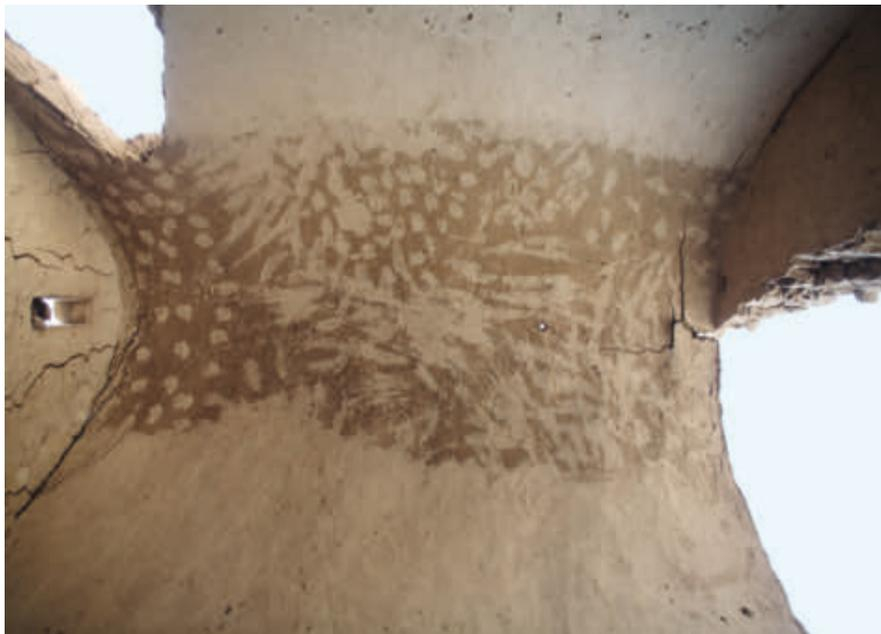
2 *Bāb*, WE 17A, Deckenspiegel mit Kalkschlämme
