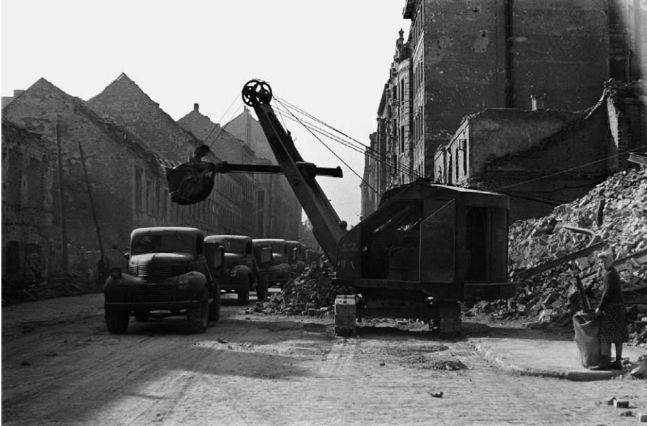
Abb. 2: Britische Bagger bei der Schuttentfernung in Wien. Österreichische Nationalbibliothek / ÖNB/Croy/CRO 1604W
