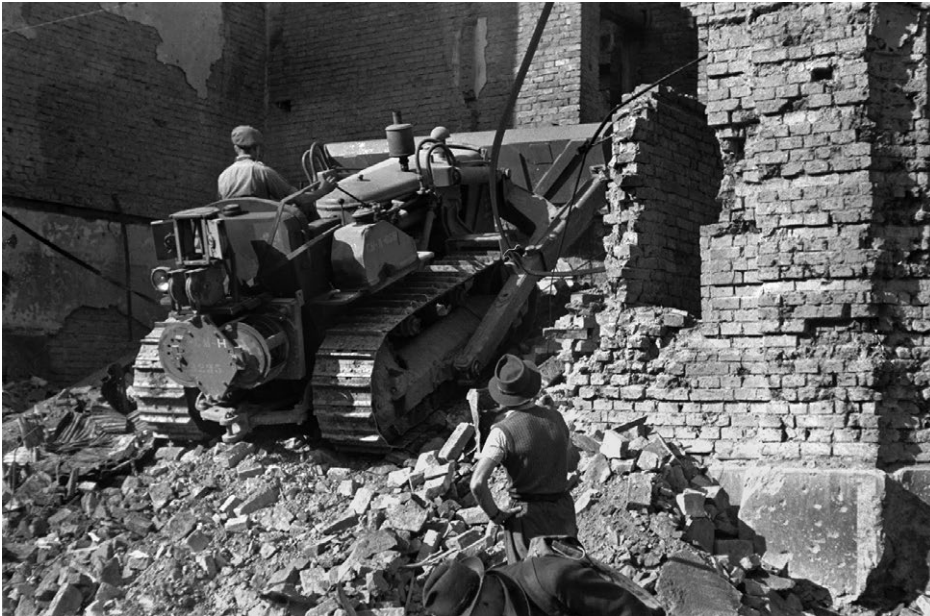
Abb. 3: Professionelle Schuttbagger in der Fasangasse in Wien. Österreichische Nationalbibliothek / ÖNB/Croy/CRO 1614W
