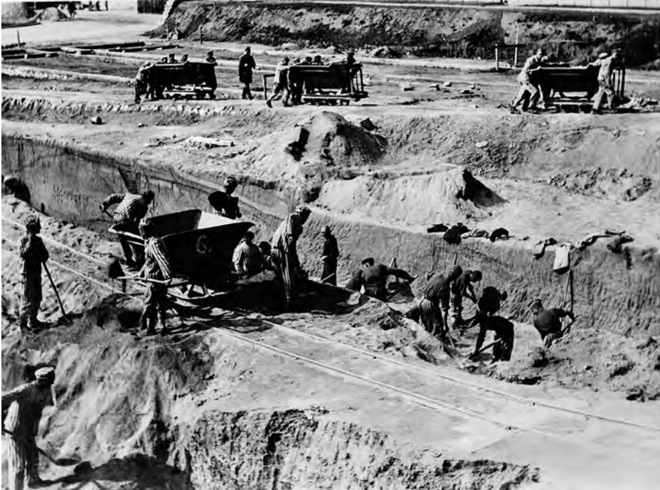
Planierungsarbeiten für das «Russenslager» und den SS-Sportplatz, 1941, © MM, Fotoarchiv, ICMP_MH_0250 = F/20/02 (Provenienz: Václav Berdych, Prag)
