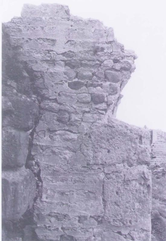
Abb. 12: M 114; Bogenwiderlager und ausgebrochener Anwölber. Blick aus Norden.
