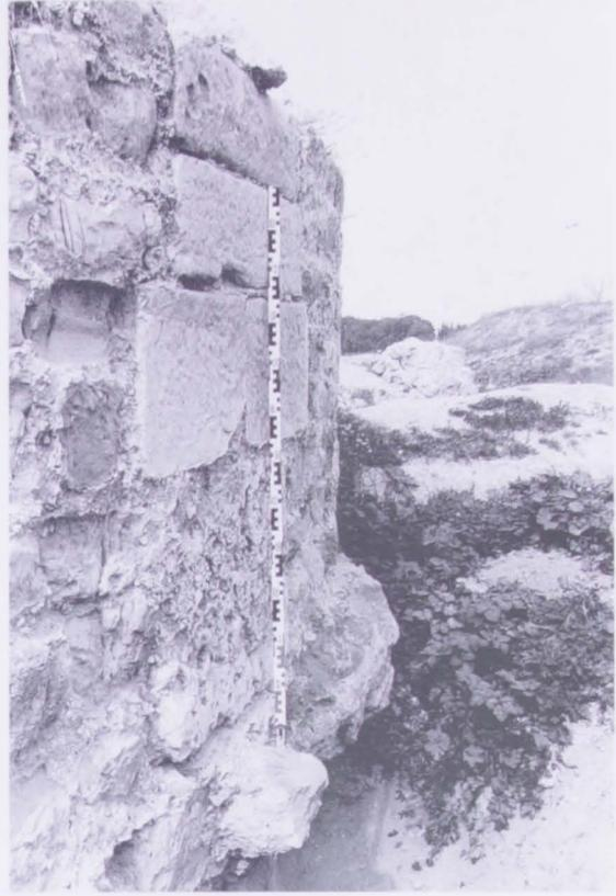
Abb. 95: Orthostat in der M 1 über der M 26; aus dem Sichtmauerverband vorkragendes Caementitium. Blick aus Südosten.
