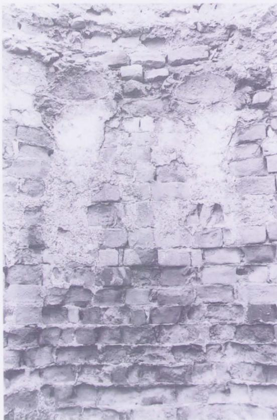
Abb. 74: Nischen A und B in R I; getünchter Feuchtputz; tiefer liegende Bereiche der M I durch Wassereinwirkung ausgewittert. Blick aus Südwesten.
