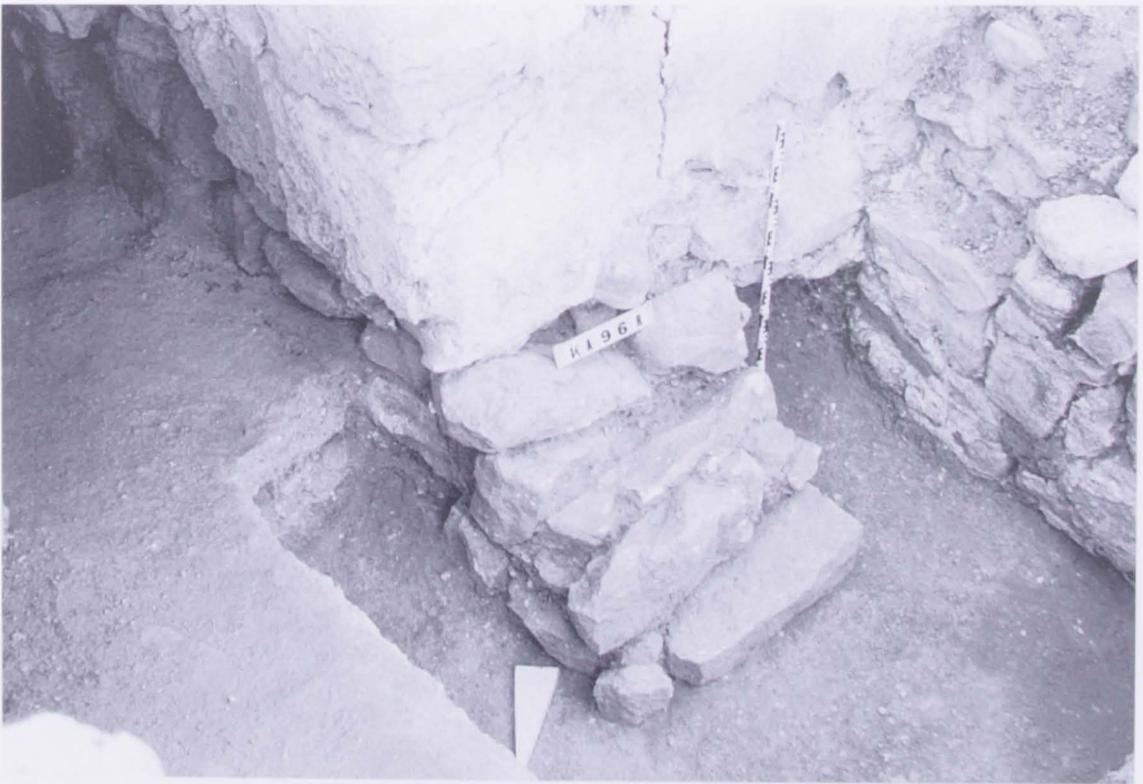
Abb. 62: Trockenfundament als Verlängerung der M 6 nach R IV. Blick aus Nordwesten.
