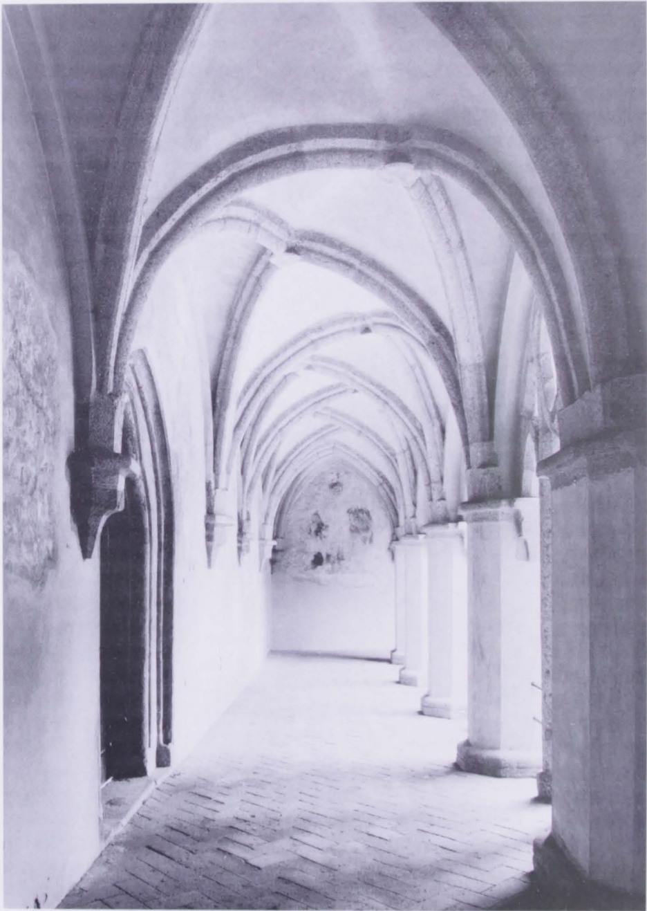
48 Klingenberg/Zvůlkov. Palas der königlichen Burg. Obergeschoß des östlichen Arkadenflügels mit dreistrahligem Springgewölbe.
