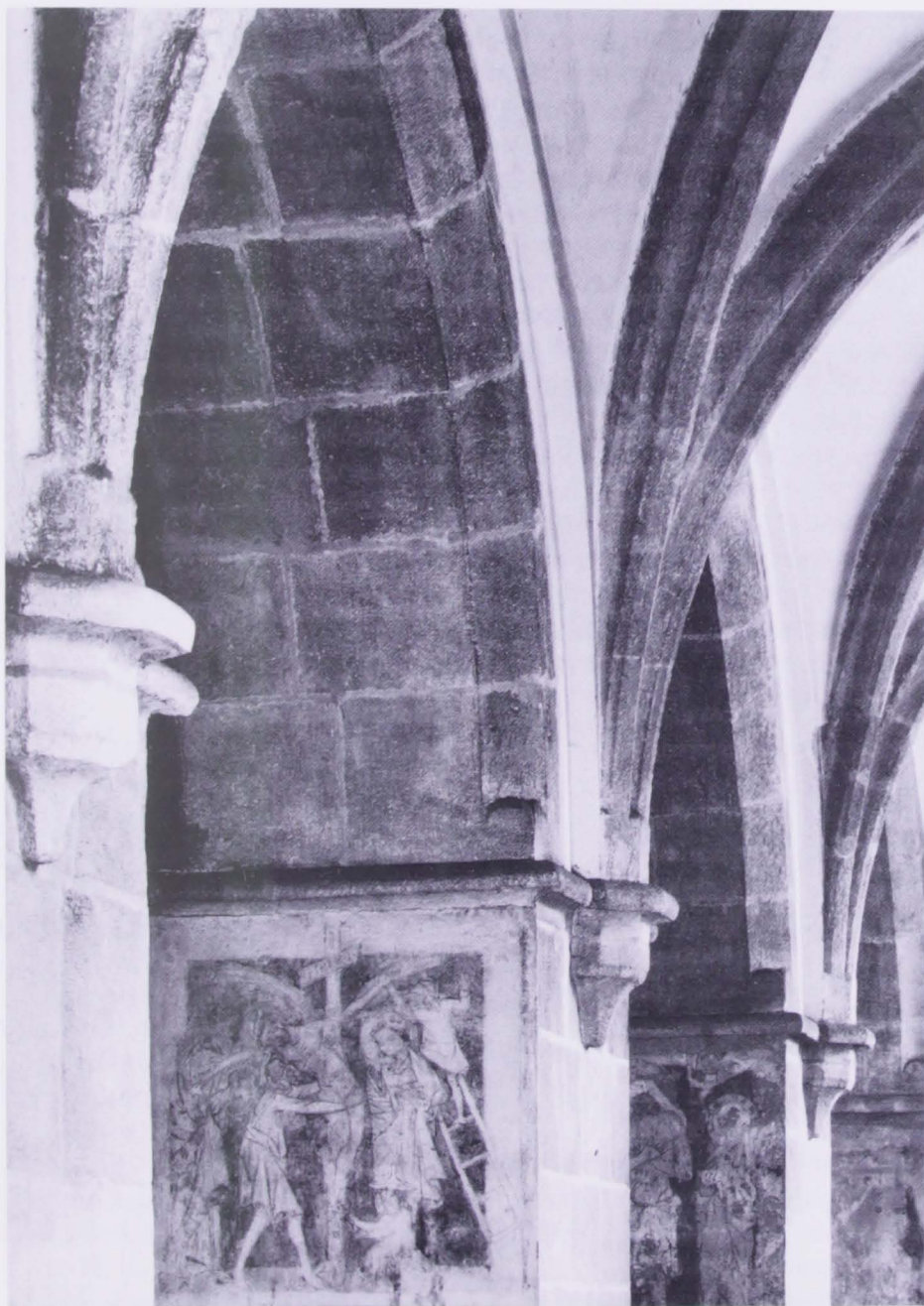
49 Písek. Stadtpfarrkirche Geburt Mariä. Gewölbeansätze im südlichen Seitenschiff.
