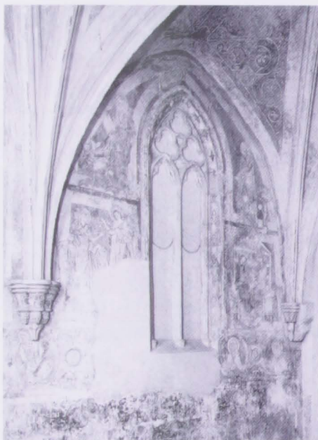
67 Göß bei Leoben. Bischofskapelle. Südwand mit Maßwerkfenster.
