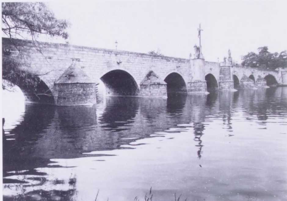
80 Písek. Steinbrücke von Nordosten.
