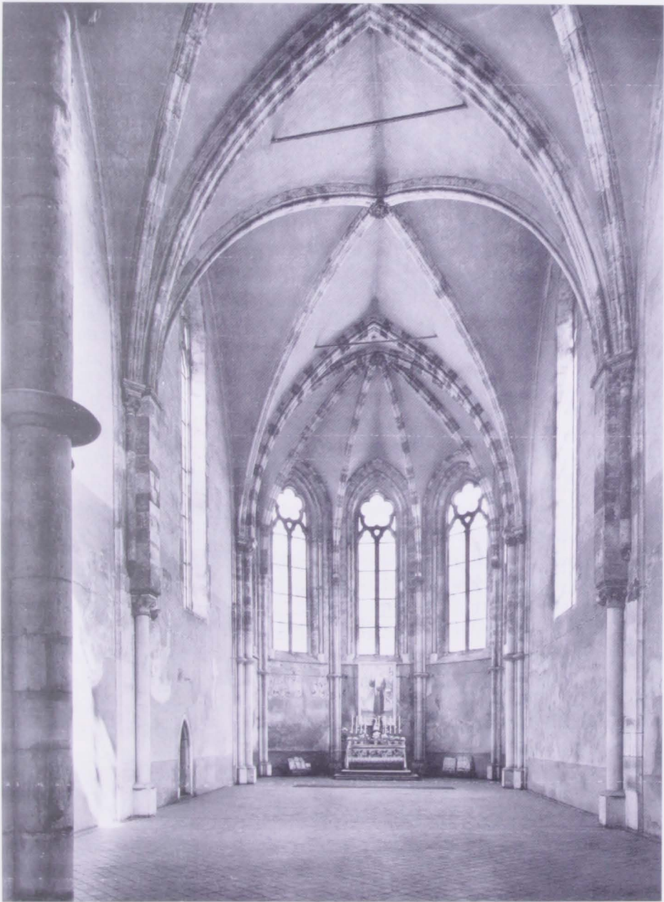
58 Prag, Salvatorkirche im Agneskloster. Interieur. Blick gegen Osten.
