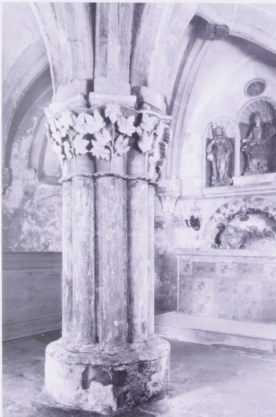
61 Kouřim. Stephanskirche. Oktogonaler Raum unter dem Mittelteil der Choranlage mit drei-strahligem Gewölbe.
