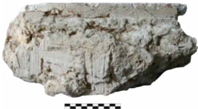
Abb. 193 Abdruck des Holzlattengeflechts an der Oberkante der Platte von Stuckfries 5 (151)
