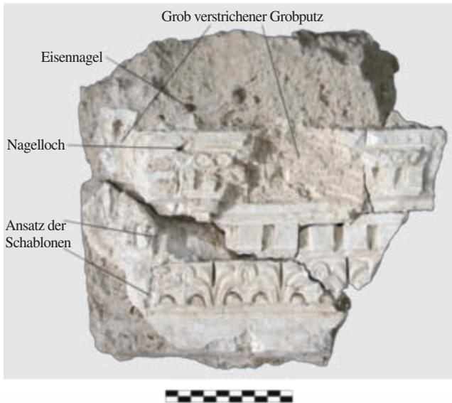
Abb. 192 Linke Raumecke von Stuckfries 3 (48) mit technischen Details
