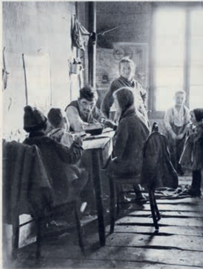
So konnten die Steyrer Arbeiterinnen in den alten Militärkasernen von 1914
