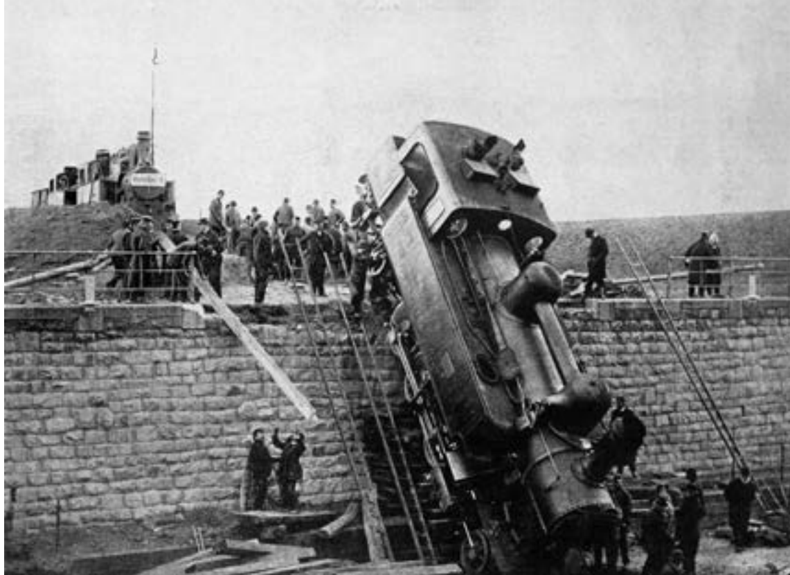
Abb. 2 Eisenbahnunfall in Wien: Durch ein Bremsversagen durchbricht die Lokomotive die abschließende Barriere eines Stumpfgleises und stürzt auf die Gunoldstraße in Heiligenstadt. Das interessante Blatt , 1. Dezember 1899, S. 5. Foto: Emil Fukarek.
