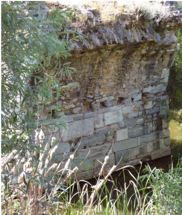
28 Brücke über den Sarı Çay (Keniös) 2008
