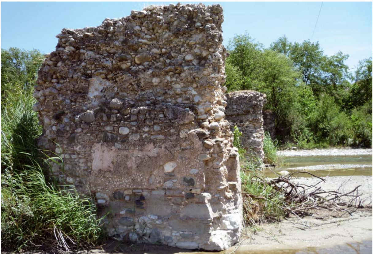
49 Pfeiler der Irmakköprü
