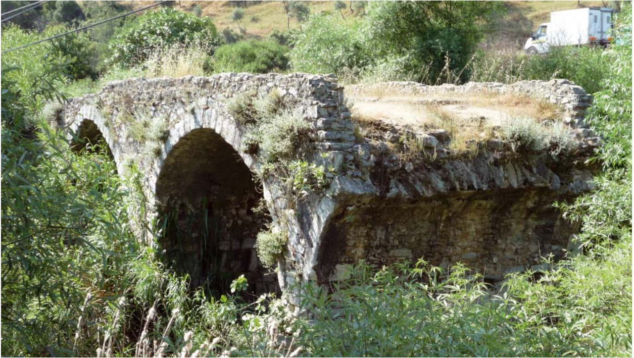
27 Brücke über den Sarı Çay (Keniös) 2008
