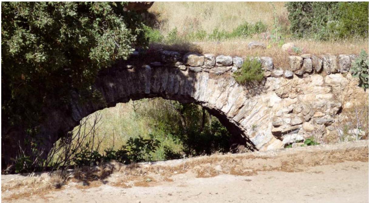
41 Alte Einbogenbrücke über einen Quellfluß des Morsynos, 8 km ö. von Aphrodisias
