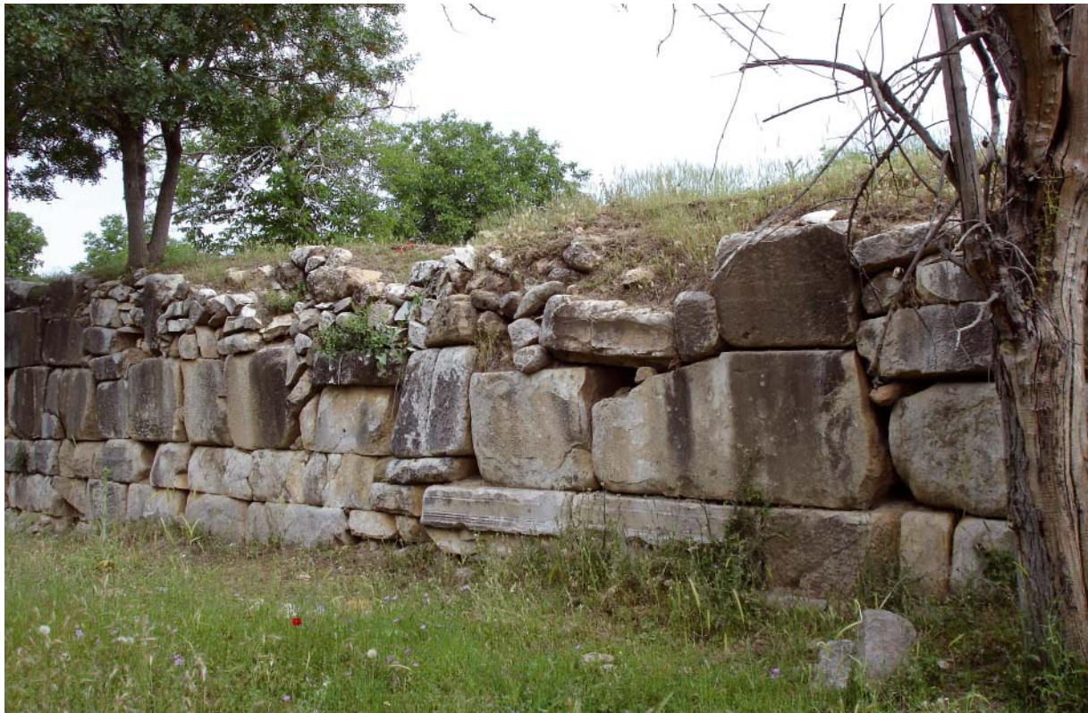
43 Frühbyzantinische Stadtmauer aus Spolien in Hērakleia Salbakēs
