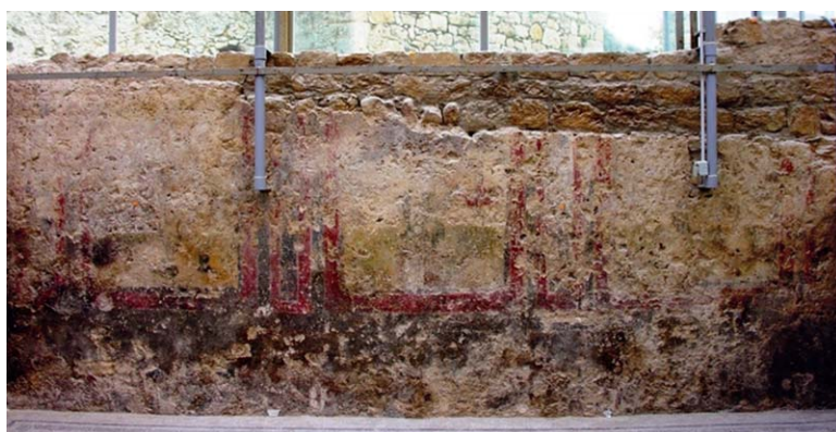
Abb. 4: Ambiente n. 40. Parete meridionale
