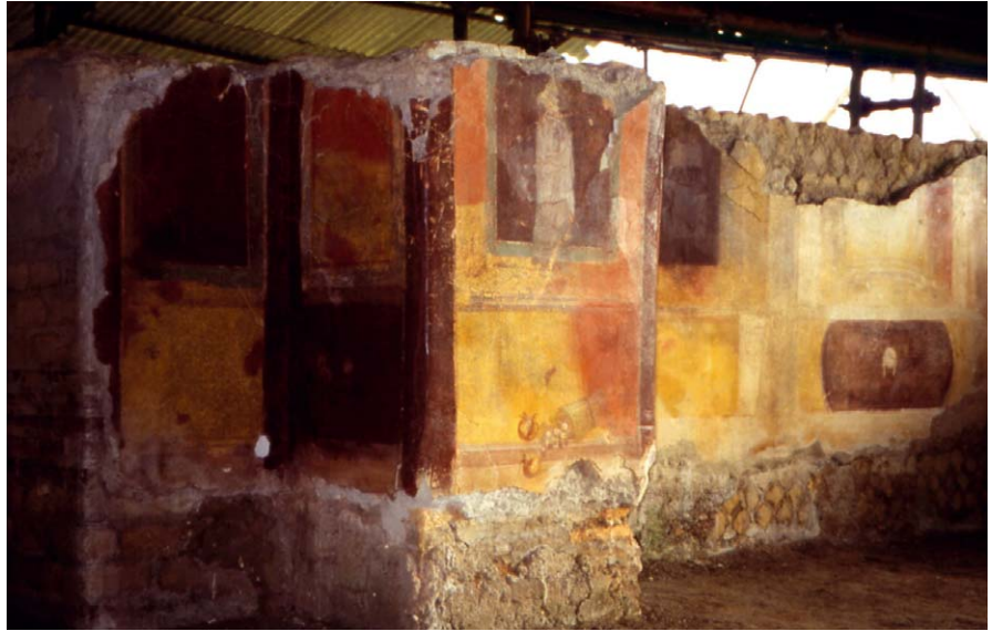
Abb. 2: Pièce 6, mur nord
