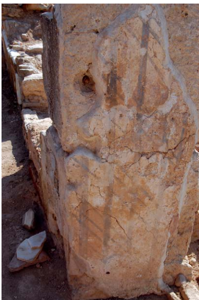
Abb. 6: Casa del cortile dorico, sala A 1207, stipite nord della porta verso l'interno dell'abitazione
