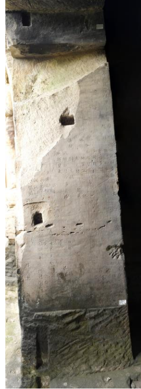
Abb. 14: Wand h der Höhle 46
